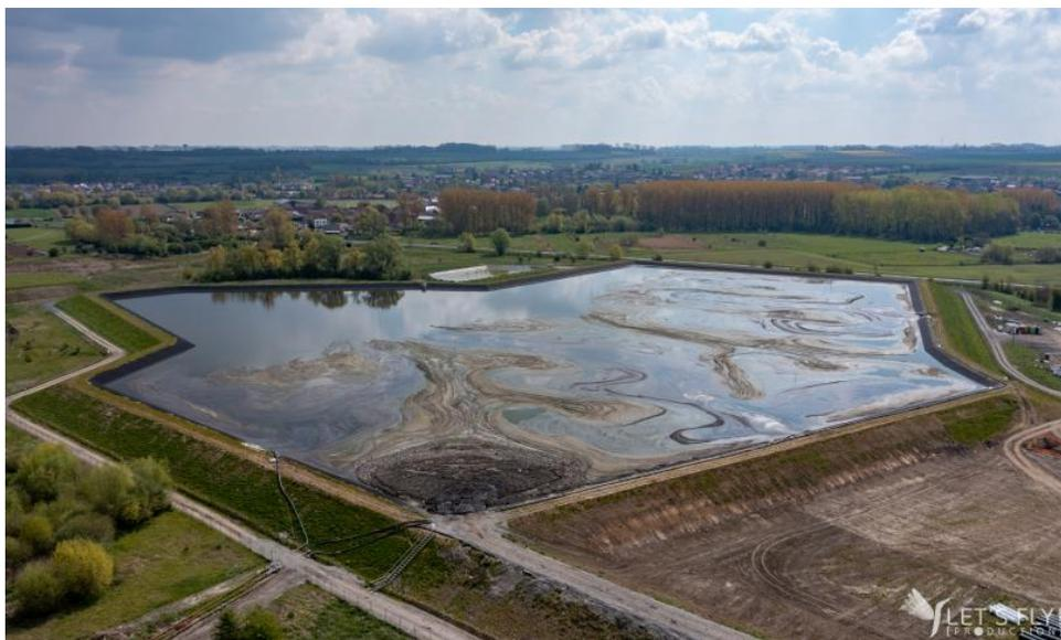
Le TD 101 A (commune de Maing) d'une capacité de 320 000 m<sup>3</sup> est actuellement en cours de construction et devrait être achevé d'ici fin juillet 2021, il fera ensuite l'objet d'une visite des services instructeurs (DREAL) afin d'obtenir l'autorisation de déposer des sédiments issus du canal.
