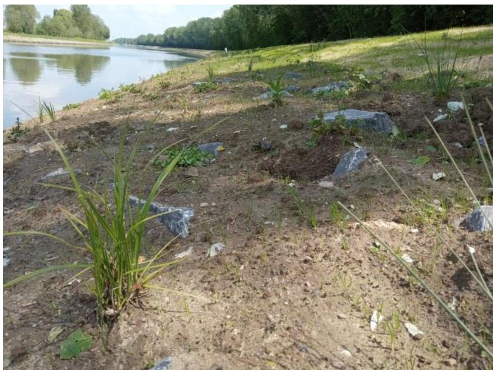
Figure 50: Illustration des enrochements percclés : en haut à gauche, enrochements avant apport du substrat , en haut à droite: enrochements après apport du substrat, en bas : enrochement percclés 3 mois après la mise en place du substrat (source : ©VNF)
